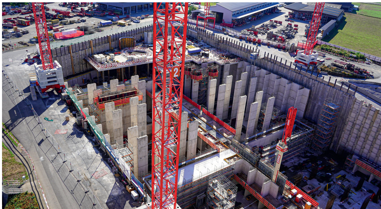
Baustelle des Technologiezentrums Laufenburg.
