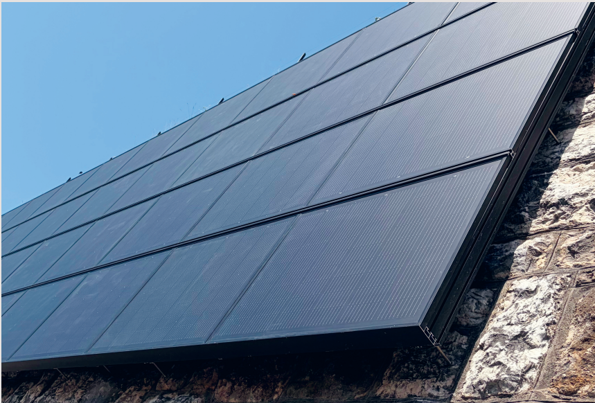
Figure 2 Le temps nécessaire à la pose des modules peut être réduit d'un facteur 4, notamment grâce au préassemblage en atelier et à la diminution du nombre d'ancrages.
