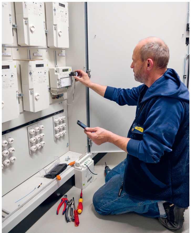
Montage von Smart Metern.
