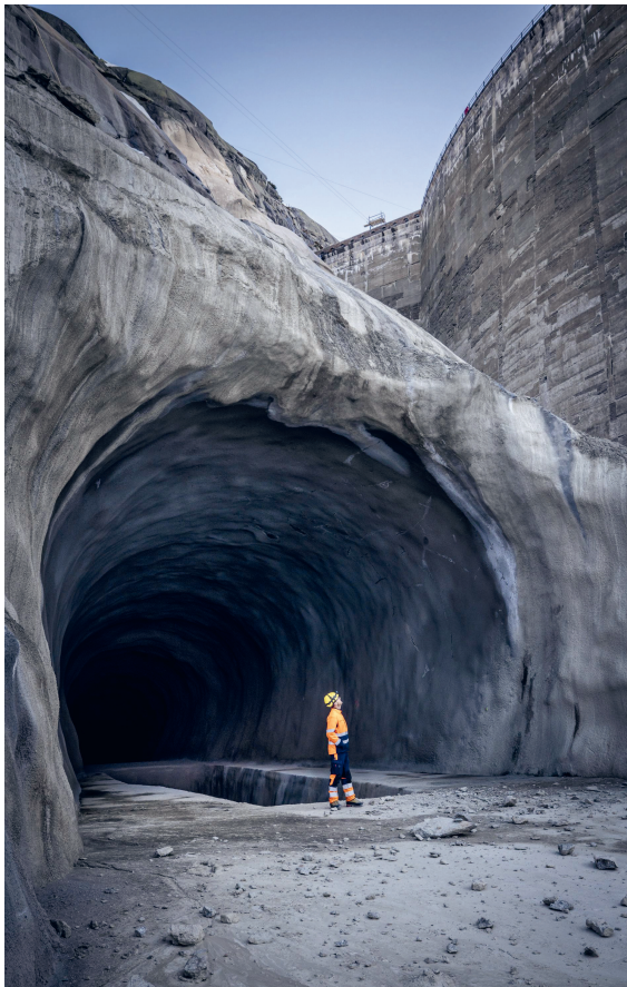
Grundablass der neuen Spitallamm-Mauer.
