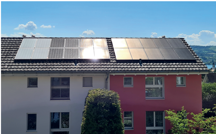
Bild 3 Blendung im Standardsolarglas, nicht jedoch auf den Folien. Von links: eine Reihe PV-Print, eine Reihe Phytonics, vier Reihen Standardmodule sowie rechts Deflect-Module. Die linken Deflect-Module deuten bereits einen Blendfleck an.
