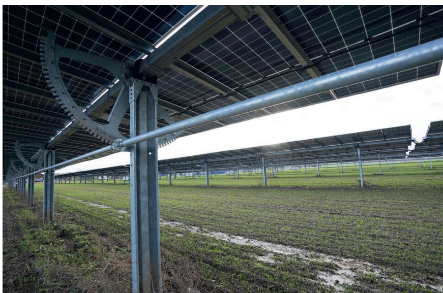
Bild 3 Einachsige Trackersysteme folgen dem Lauf der Sonne.
