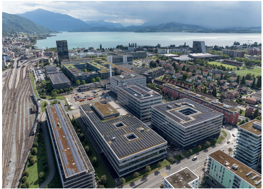
Installations photovoltaïques sur le Siemens Campus, à Zoug.
