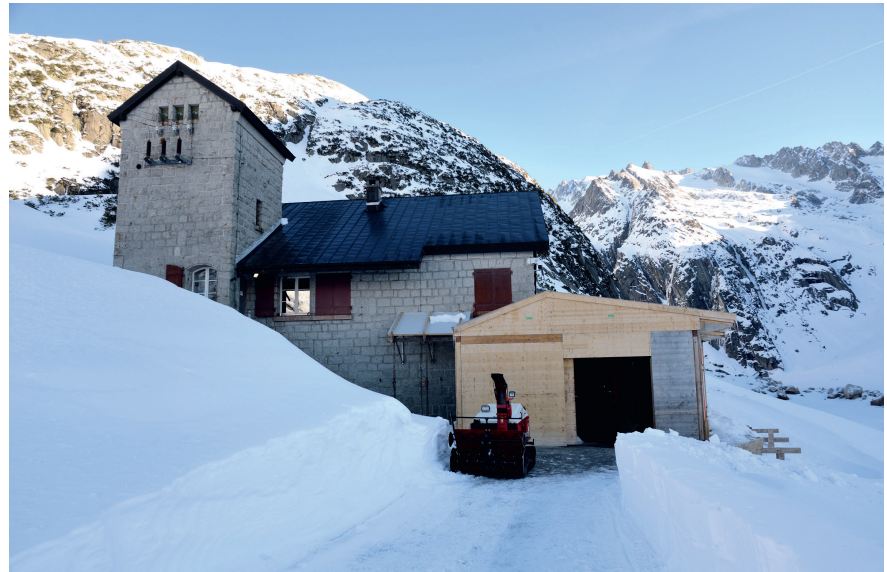
Bild 1 Das Wärterhaus mit der temporären Einhausung.
