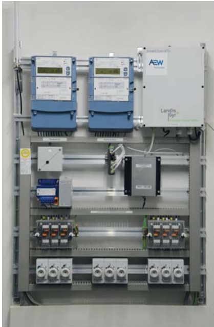
Bild 2 Überwachung und Steuerung der Transformatorenstation Niederwil mit paralleler Energieabrechnung.
