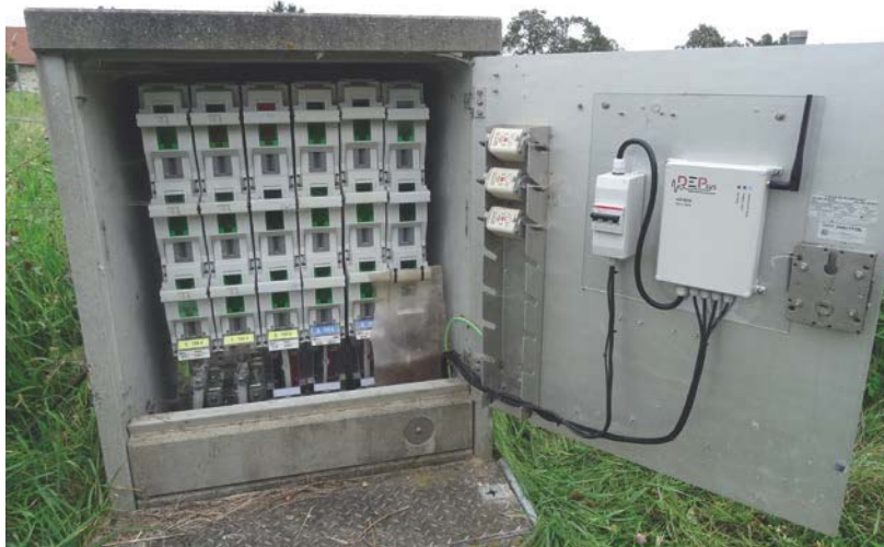
Bild 2 Verteilkasten mit einem GridEye-Modul.
