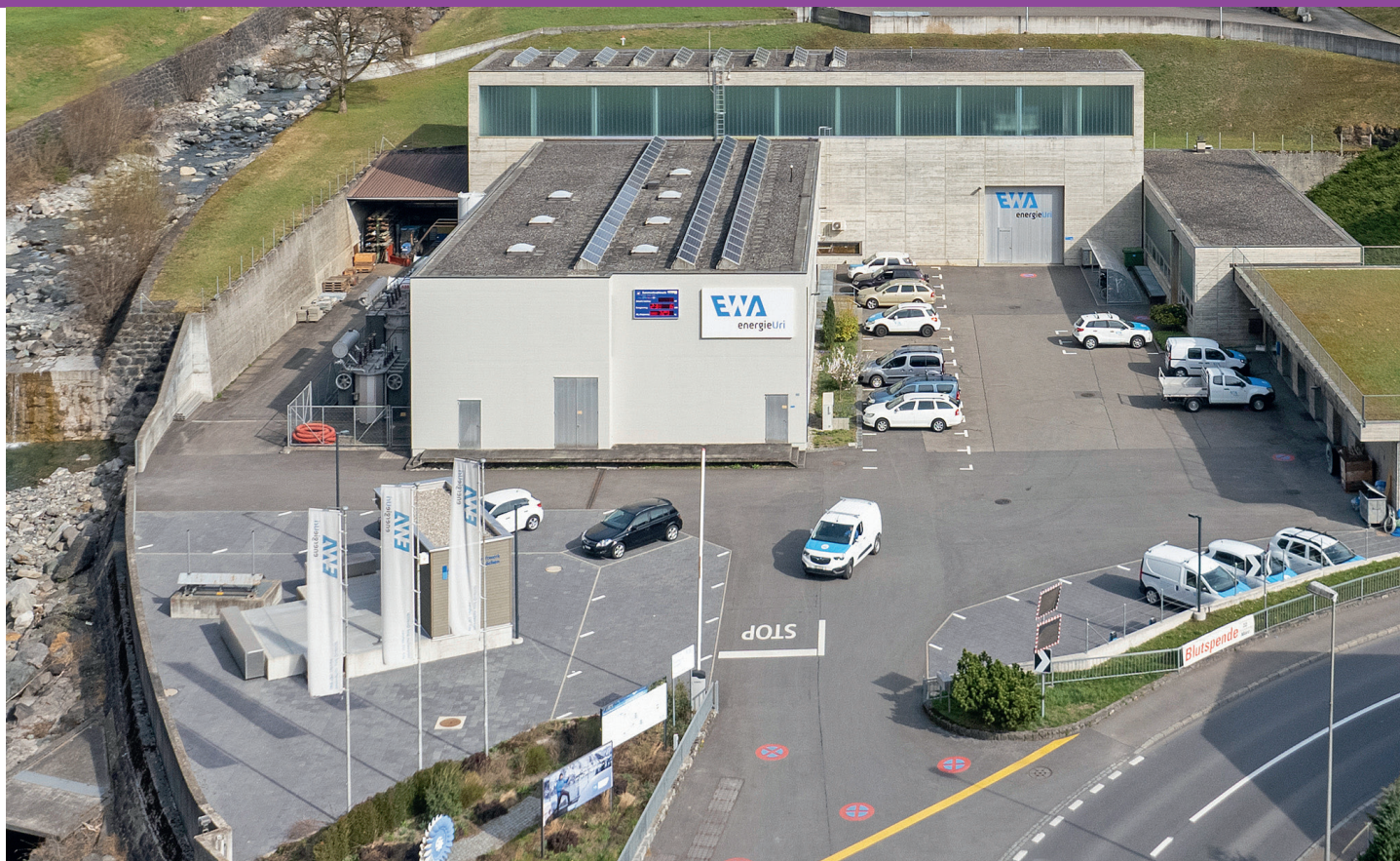
Das Wasserkraftwerk Bürglen versorgt über 22 000 Haushalte.
