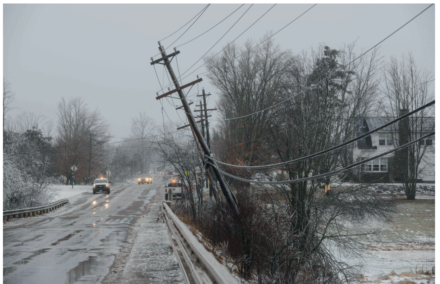
Bild 2 Mehrere Zentimeter dicke Eisschichten auf den Leitungen liessen im Jahr 2017 die Masten wie Dominosteine fallen. 600 Masten mussten ersetzt werden, knapp 300 000 Kunden waren ohne Strom.
