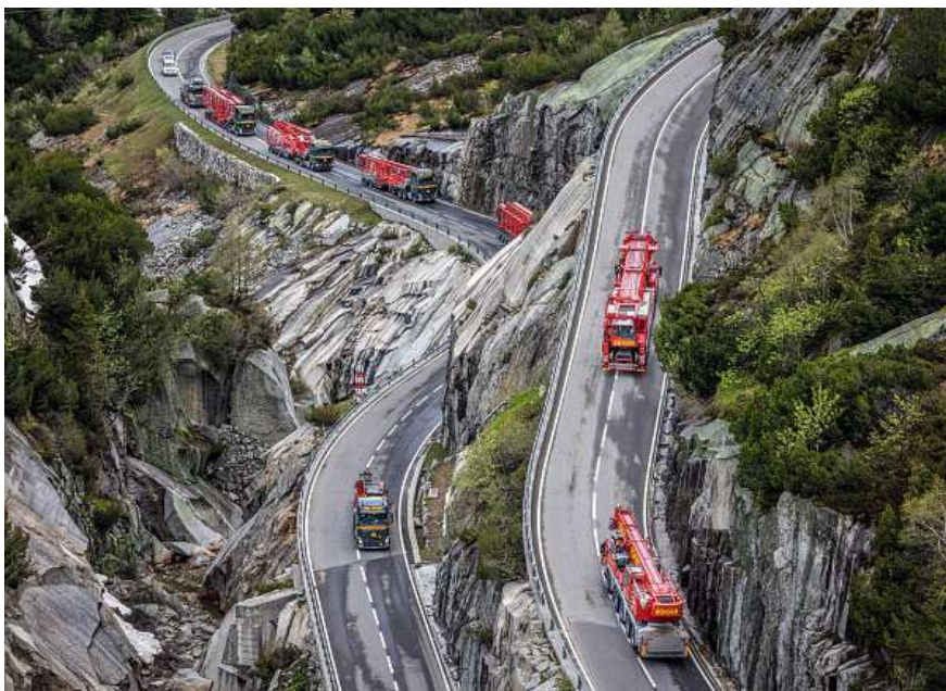
Inalpe d'un autre genre : les grues à tour et les grues sur roues sont transportées jusqu'au chantier.
