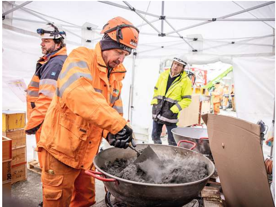
Non, on n'est pas à la cantine. Ici, on réalise des tests sur le béton frais.
