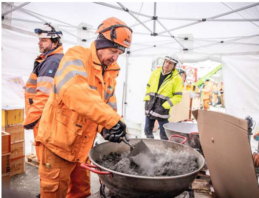
Kein Blick in die Kantine. Hier werden Prüfungen an Frischbeton durchgeführt.
