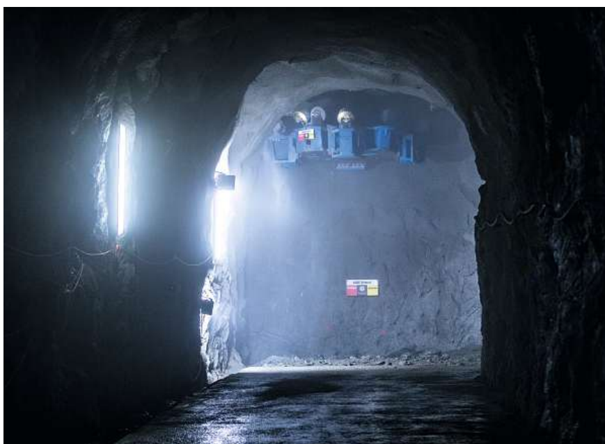
Der Bohrkopf ist bereit, um einen Liftschacht nach oben in den Fels zu treiben.
