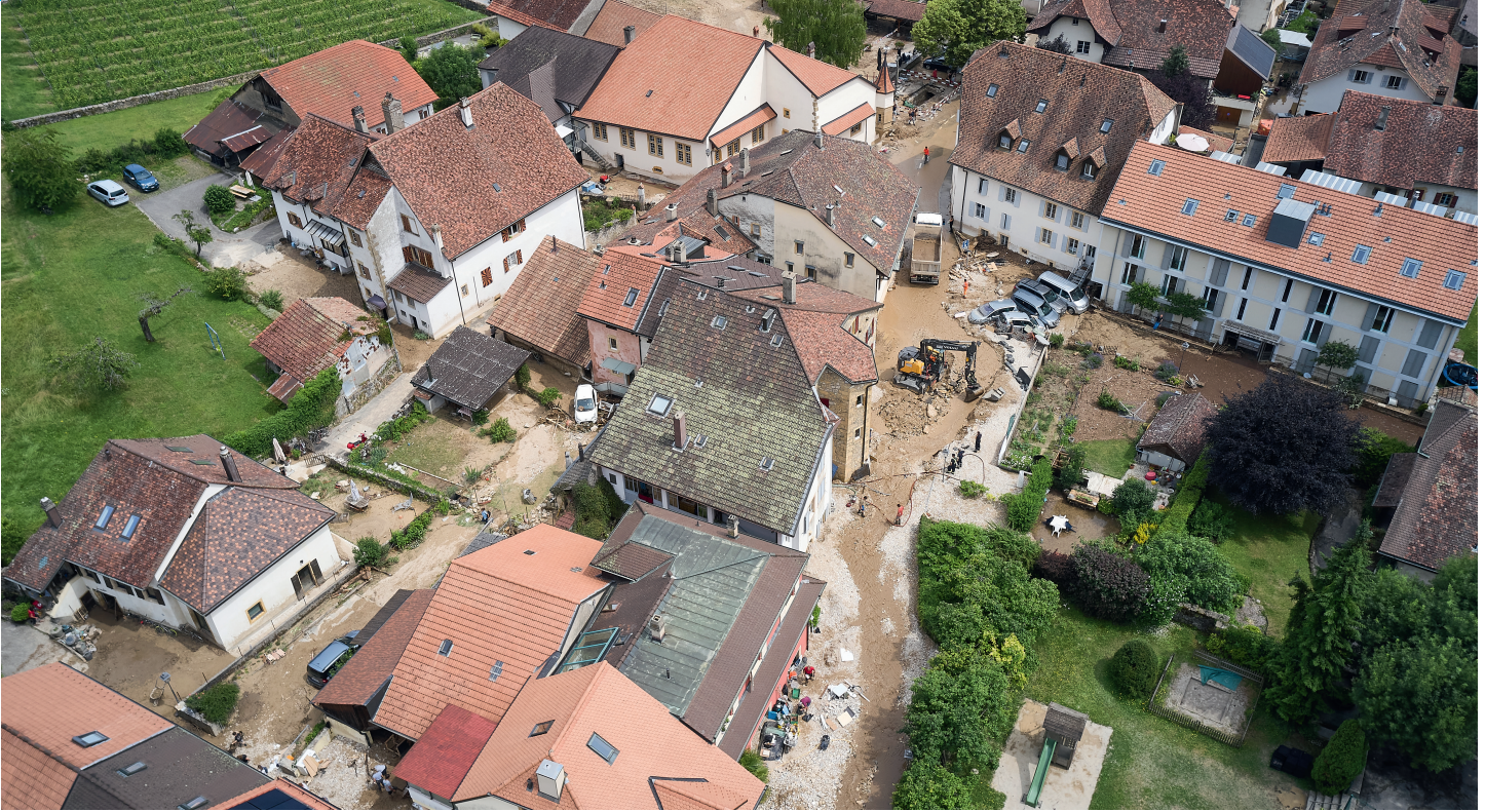
Vue aérienne du village de Cressier suite aux intempéries du 22 juin 2021.
