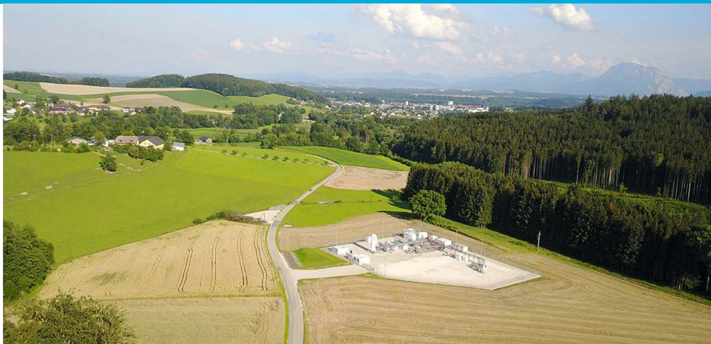
Die Anlage im österreichischen Pilsbach.
