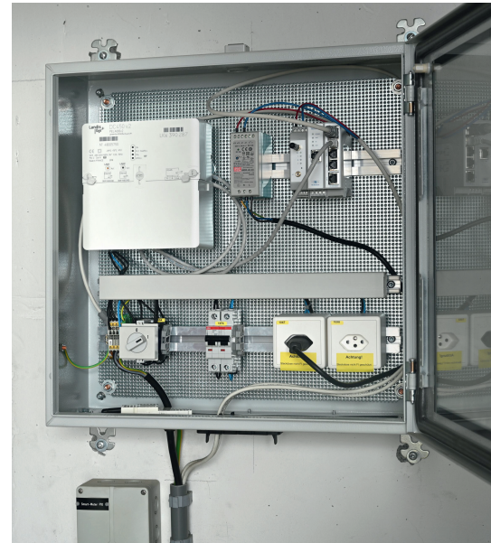
Der Datenkonzentrator sammelt die Zählerdaten und leitet sie weiter an das Rechenzentrum.
