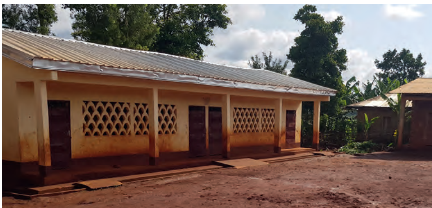
Grâce à Électriciens sans frontières - Suisse et à ses donateurs, cette école primaire située au Cameroun devrait bientôt avoir accès à l'électricité et à l'eau potable.
