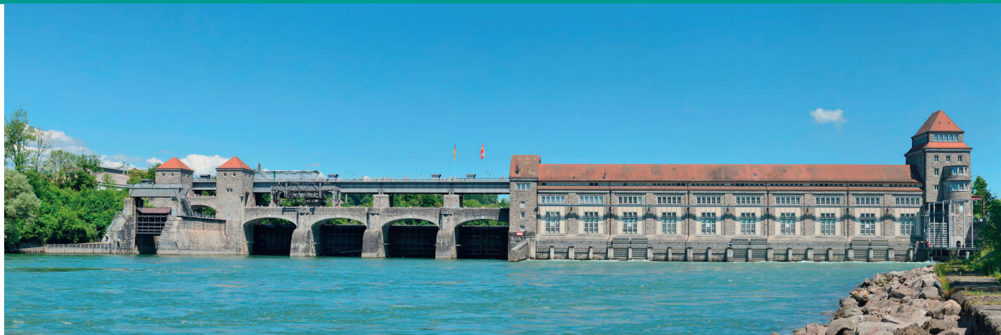
Staufstufenunterseite des Kraftwerks Laufenburg.
