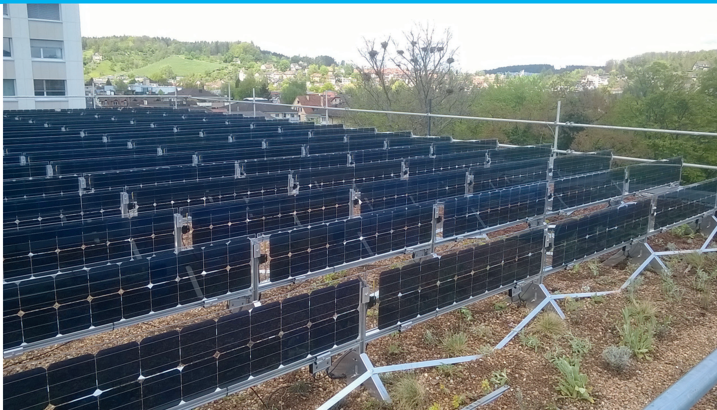
Vertikal montierte, bifaziale Lamine in Ost/West-Ausrichtung in schmaler, 20-zelliger Ausführung auf einem Gründach in Winterthur.
