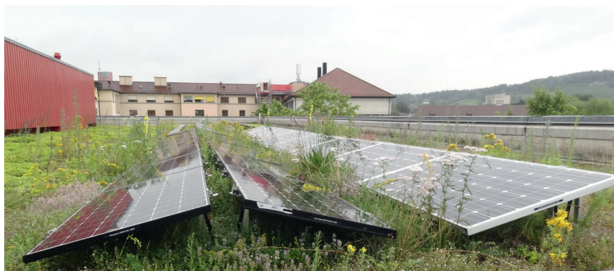
Bild 1 Der Bewuchs auf Gründächern kann zu einer nachteiligen Abschattung der PV-Anlage führen. Wartungsarbeiten werden wiederum durch eine dichte Belegung mit PV-Modulen erschwert.
