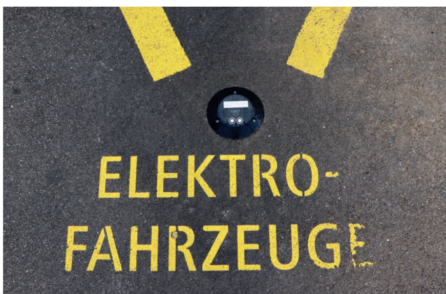
Figure 2 Chaque place de stationnement réservée à la recharge de véhicules électriques a été équipée d'un capteur. Les conducteurs peuvent ainsi, grâce à une application, voir quelles sont les stations de recharge actuellement disponibles.
