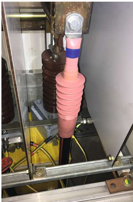
Bild 1 Hinter dem Kabelanschluss sind die temporär montierten kapazitiven Spannungsteiler zur Messung der Phasenspannungen im MS-Feld der weiterführenden Leitung sichtbar.
