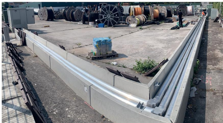
**Figure 2** Câble à air comprimé moyenne tension (36 kV) avec trois phases juxtaposées, posé dans un canal de câbles.
